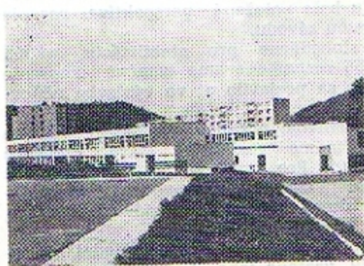
Nová základná škola na sídlisku SNP.
