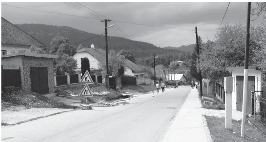
Oprava kanála v obci
